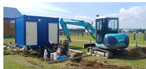
4ドア浄化槽接続工事
