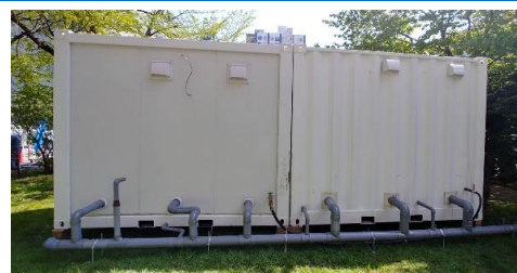
2ドア給排水管接続
