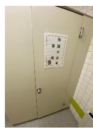
体調不良者専用トイレ
